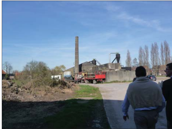
De roterij is een verzameling van bedrijfsgebouwen, schuren, een schouw en diverse constructies in functie van de bedrijfsvoering.
